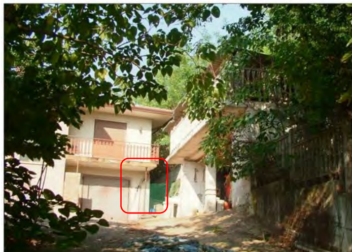
Fabbricato evacuato per frana in via Campagnolo
